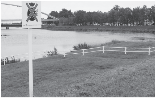
▲広域にわたって設置された安全柵
